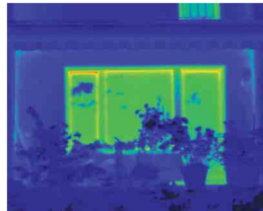
Nach dem sorgfältigen Einbau neuer Schüco Alu Inside-Energiesparfenster beweist die Thermografie den hohen energetischen Nutzen der Investition. Der ursprüngliche Energieverlust wird nahezu vollständig vermieden.
