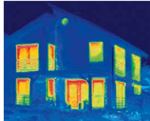
Infrarotaufnahmen – Thermografien – zeigen deutlich, wo ein Haus unkontrolliert Energie verliert. Rot bedeutet Wärme- und damit Energieverlust.
