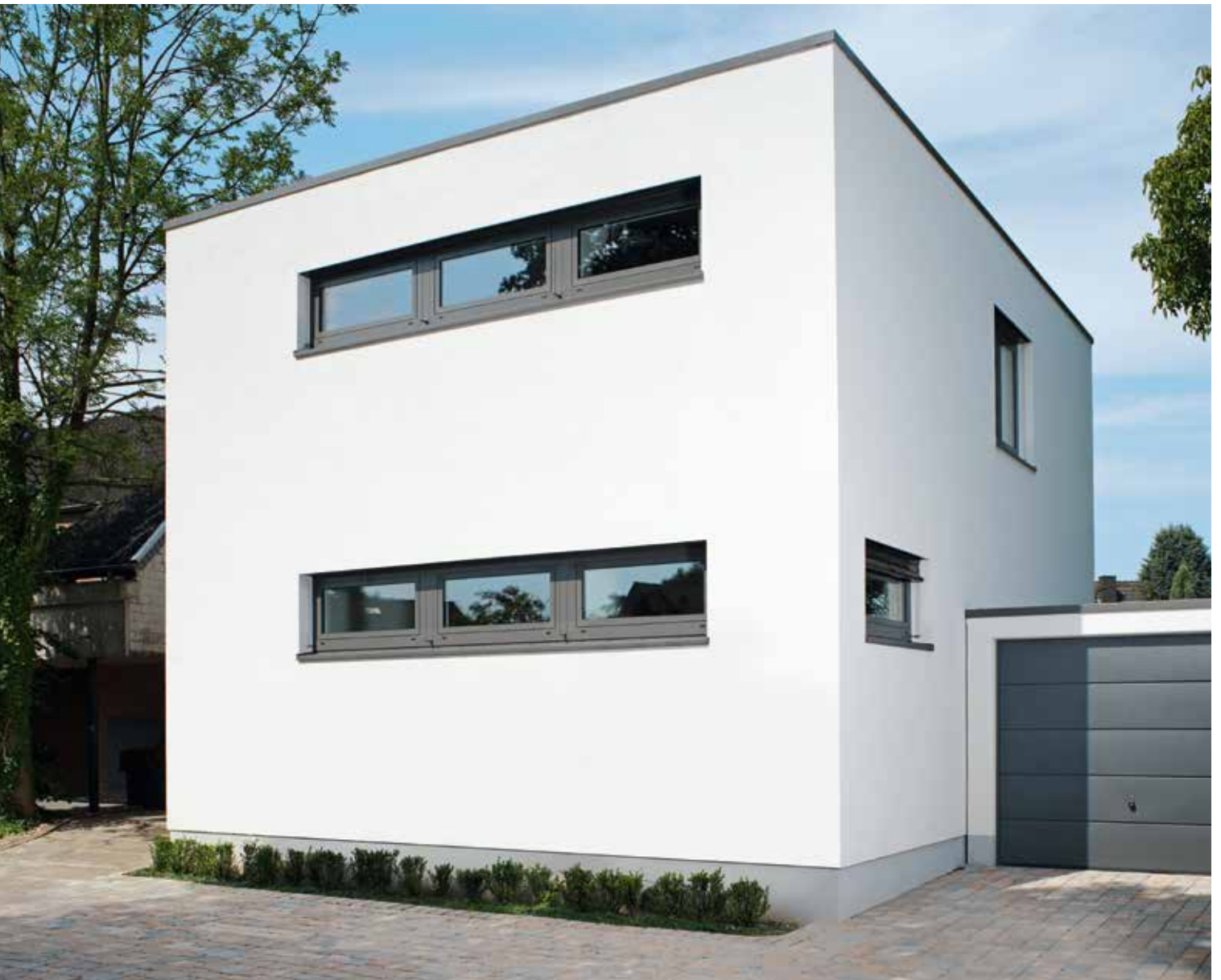
Fenster sind dominante Gestaltungselemente.
